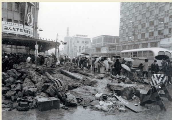
小林百貨店前 西堀の埋め立て工事が進む(昭和39年2月 桜井進一撮影)
