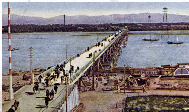
二代目萬代橋に設置された暴風警報信号標(大正期)
