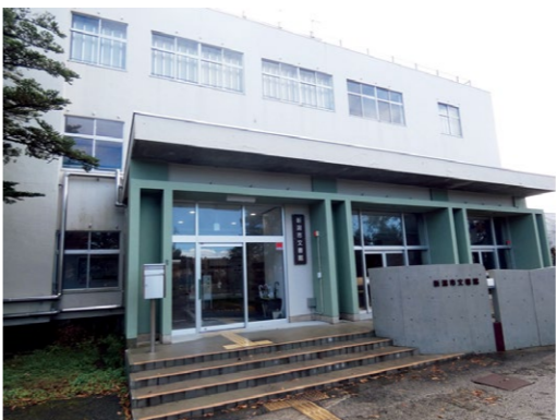
旧太田小学校(新潟市北区)の校舎を改修
