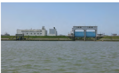
西川水門と排水機場(左) 排水機場の場所に移転前の川越波切御名号堂があった。
