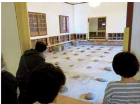
旧新潟税関庁舎改修工事見学会（4月16日）
