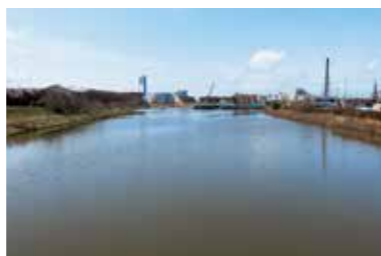
焼島橋からの景観(山の下閉門排水機場方向)
