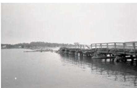
写真2 新潟地震で損壊した松浜橋(新潟市蔵)
