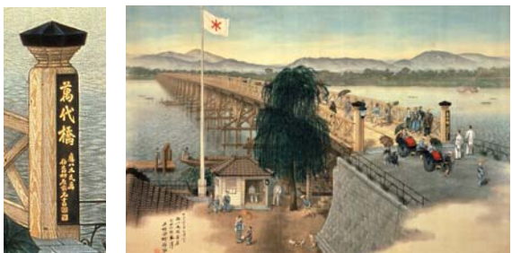
「新潟萬代橋図」(網本着色 明治21年 当館所蔵) 部分拡大
